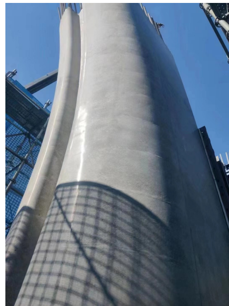
山东青岛李沧快速高架项目2023.5.1
